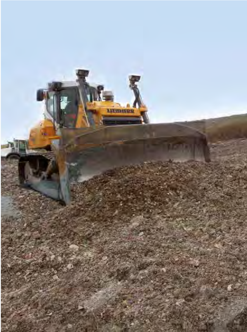
Der nach der mechanisch-biologischen Behandlung verbleibende Rest wird auf der Deponie eingebaut.
