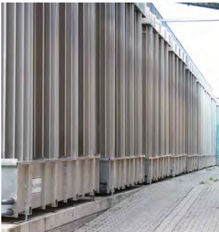
Blick auf die Luftkühler der BA.
