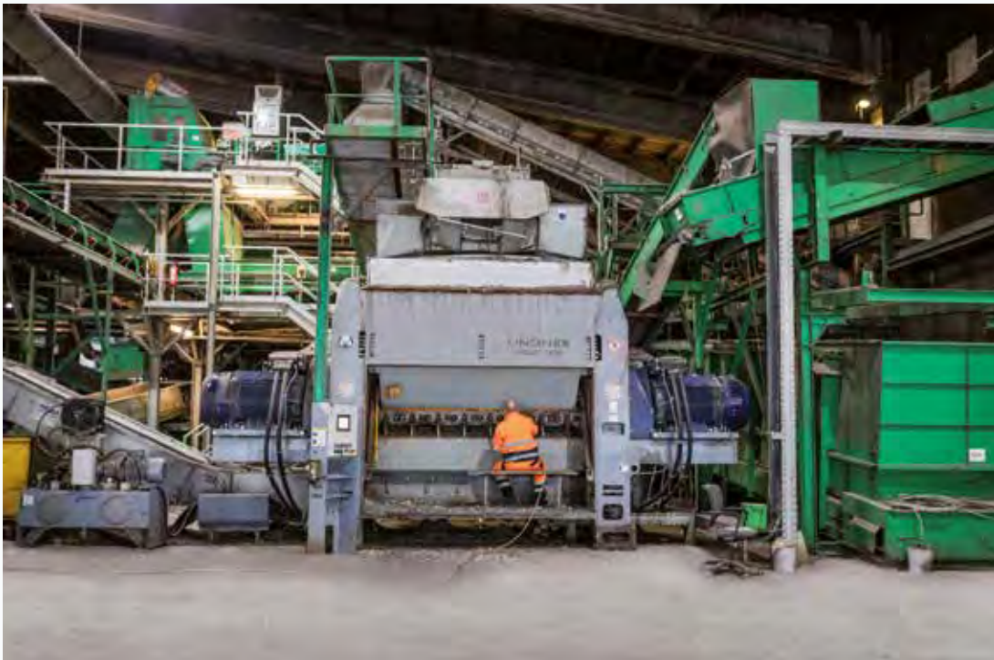
Wartungsarbeiten am Nachzerkleinerer in der EBS-Anlage.
