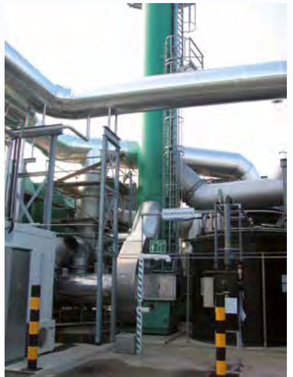
Anlage zur Abluftbehandlung mit zentralem Schornstein.
